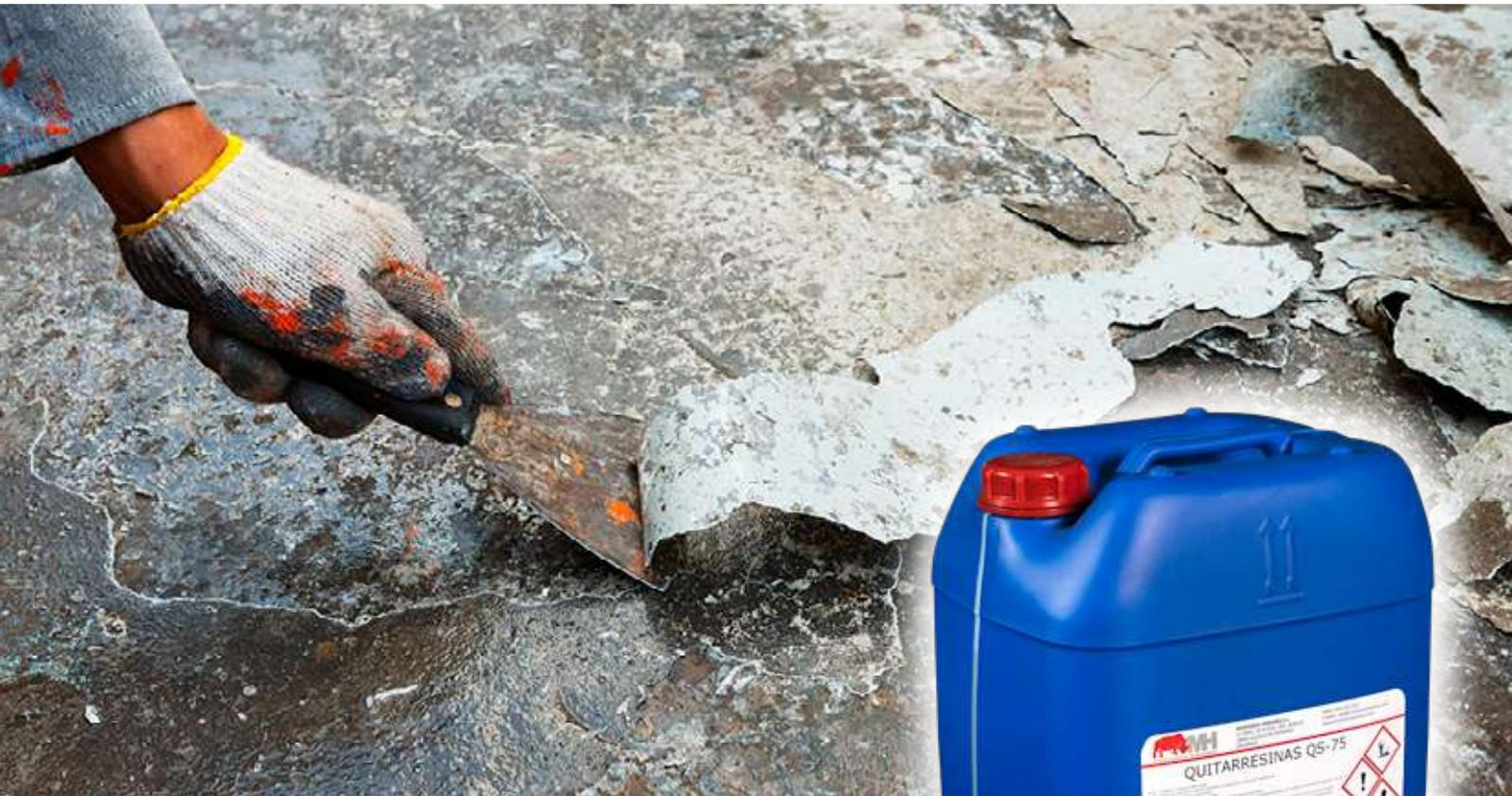
Líquido muy efectivo para la eliminación de resinas y lacas de curado del hormigón
